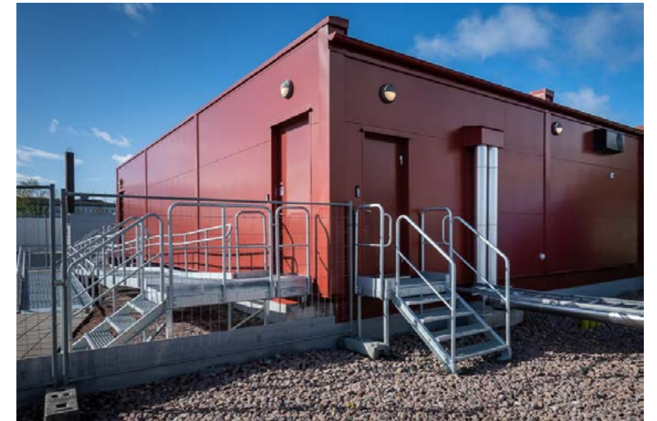
Edge datacentermodul Foto; Swedish Modules
